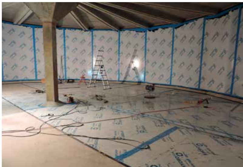
Halvveis i prosjektet
