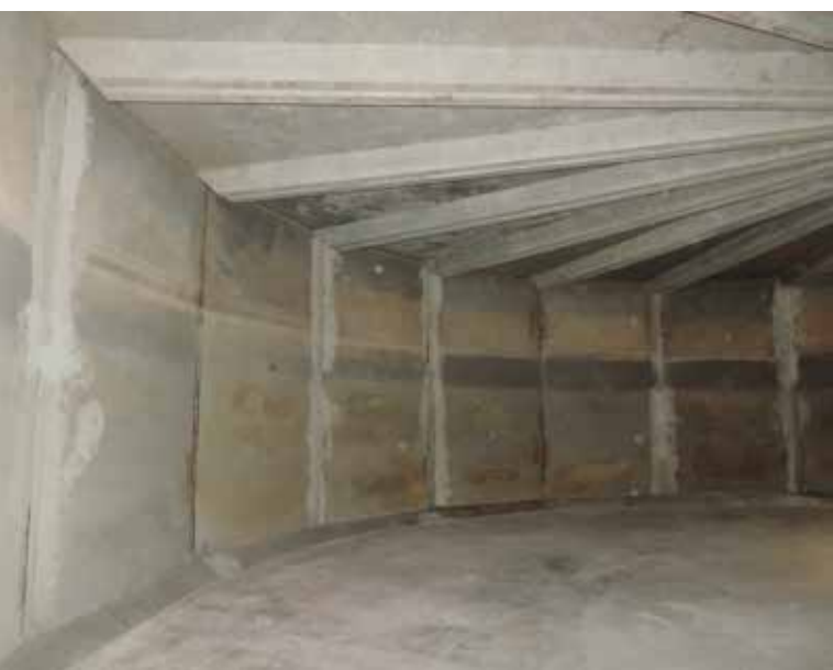
Bilde av høydebassenget før rehabilitering.
